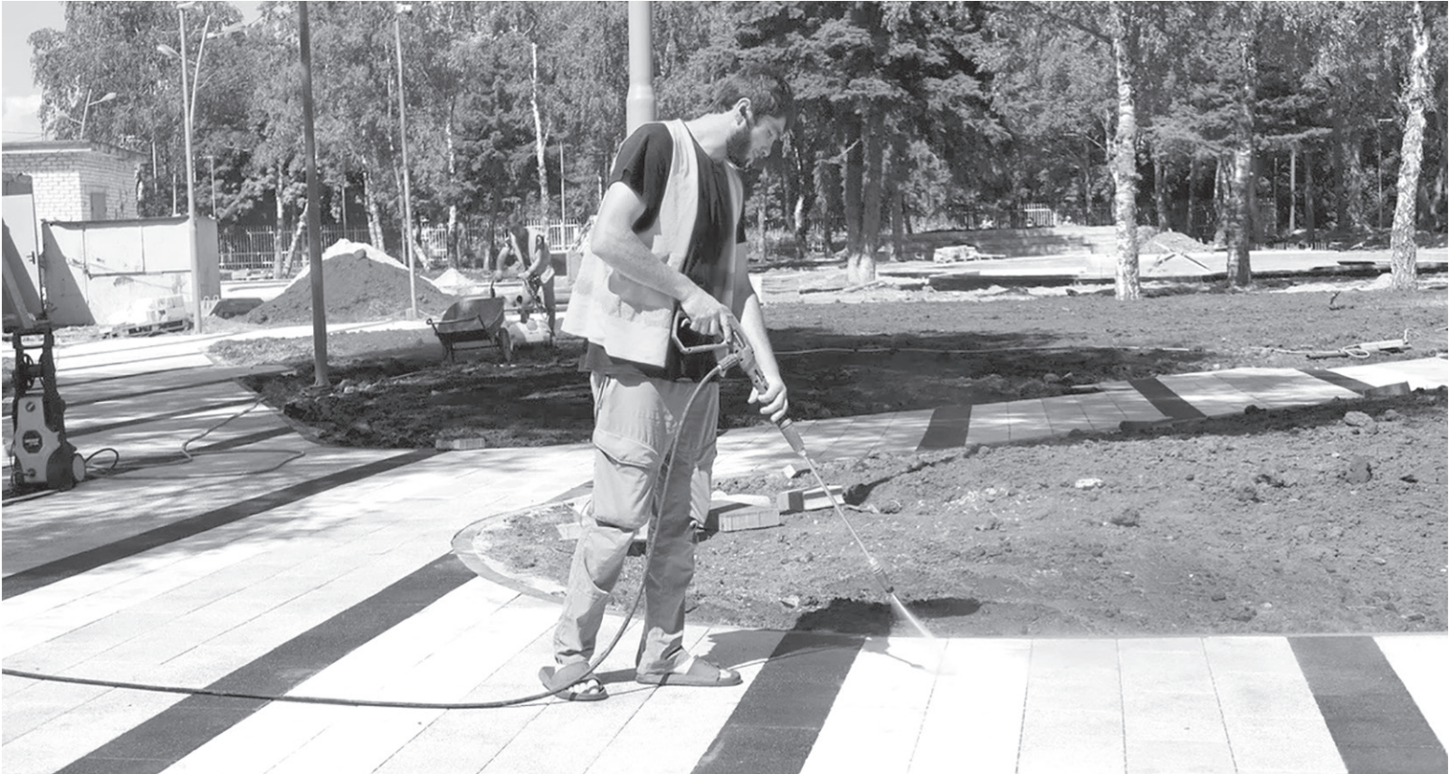
На благоустраиваемой территории нового парка кипит работа
